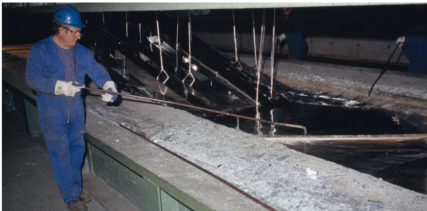
Intervention dans un bain de galvanisation.
